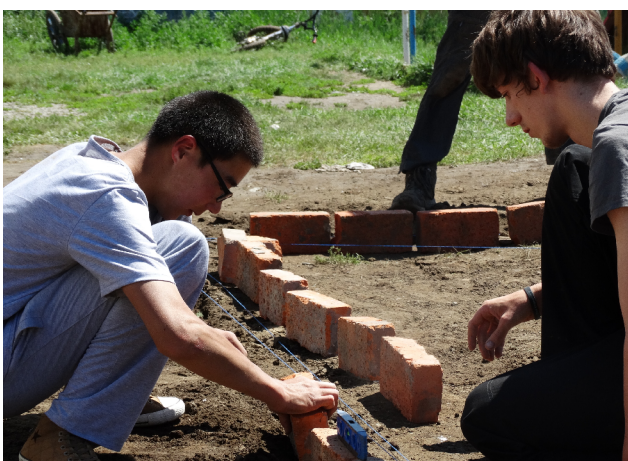
Temulamarjing arbeitet sehr exakt: Hier misst er beim Bau des Basketballplatzes eine Mauer aus.
