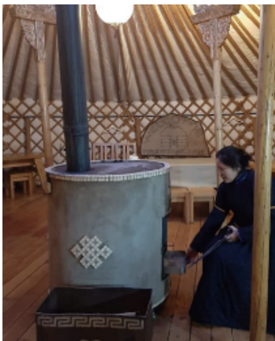
Im Jurtenrestaurant in Betrieb: Ein schöner Ofen gebaut von W. Frieske.
